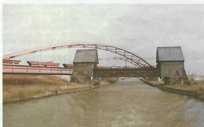
Automaticke bezpečnostní stavidlo na Středozemním kanálu
