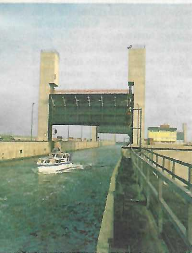
Plavební komora Kreekrak má rozměry 320 krát 24 metrů
